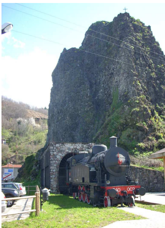
Intervento di messa in sicurezza dei dogliani
