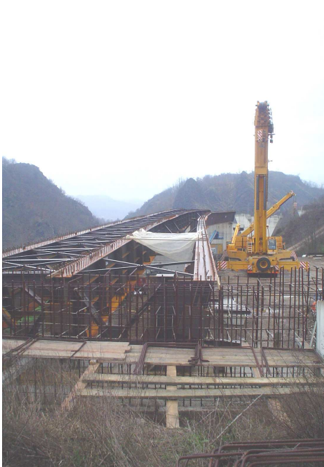
Le travi del viadotto messe in opera
