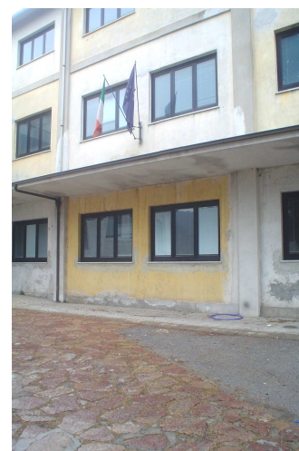
I locali al pianterreno della scuola media
