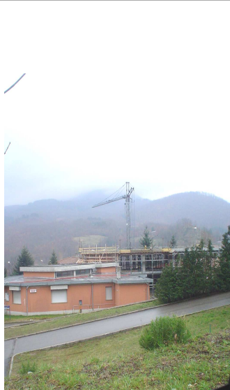
L'area Socio-Sanitaria con il nuovo poliambulatorio in costruzione
